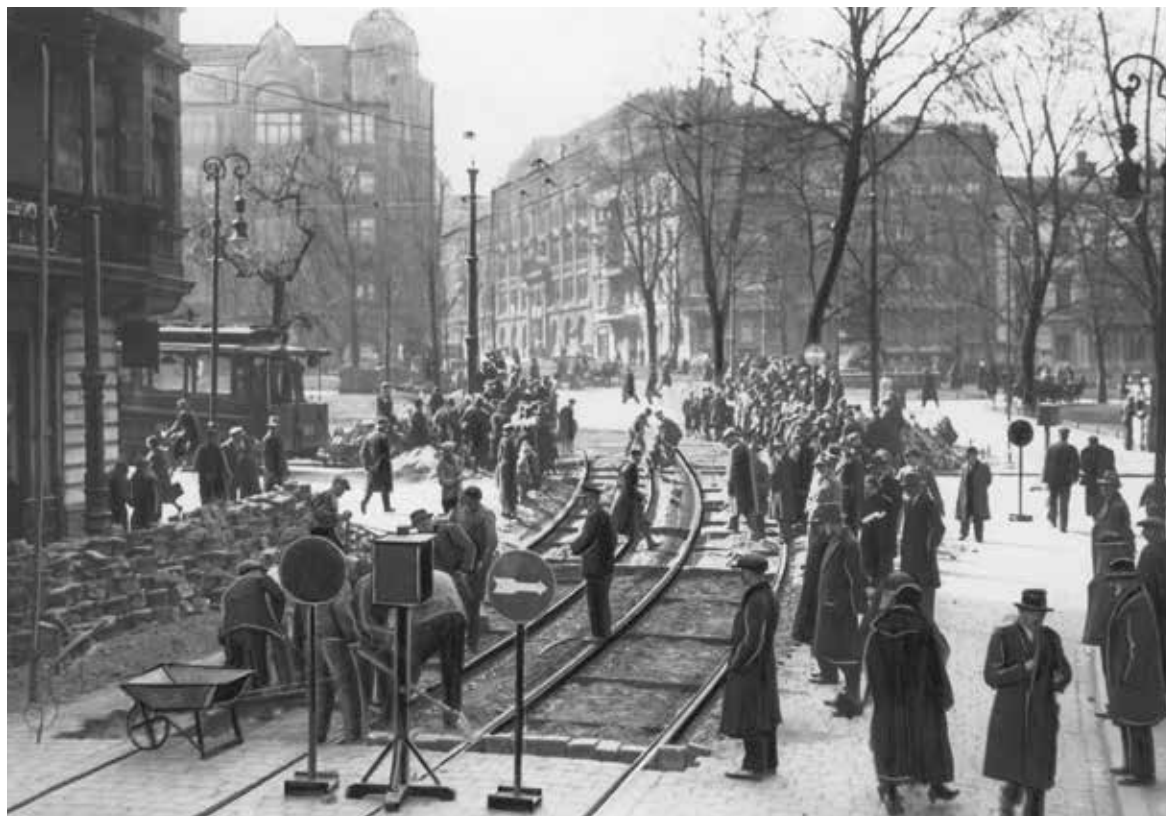
Budowa linii tramwajowej na pl. Nowomiejskim (dziś pl. Ratajskiego), 1934 r.
