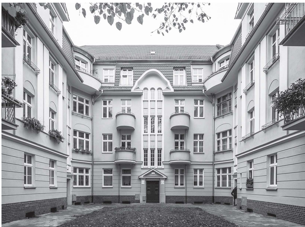
Joseph Leimbach, kamienica DBWBV przy ul. S. Karwowskiego z 1914 r., fot. K. Ślächciak
